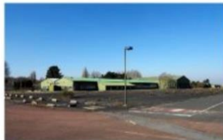
Une grande partie des anciens bâtiments vont être conservés et réhabilités. PHOTO CHRISTOPHE LEFEBVRE
